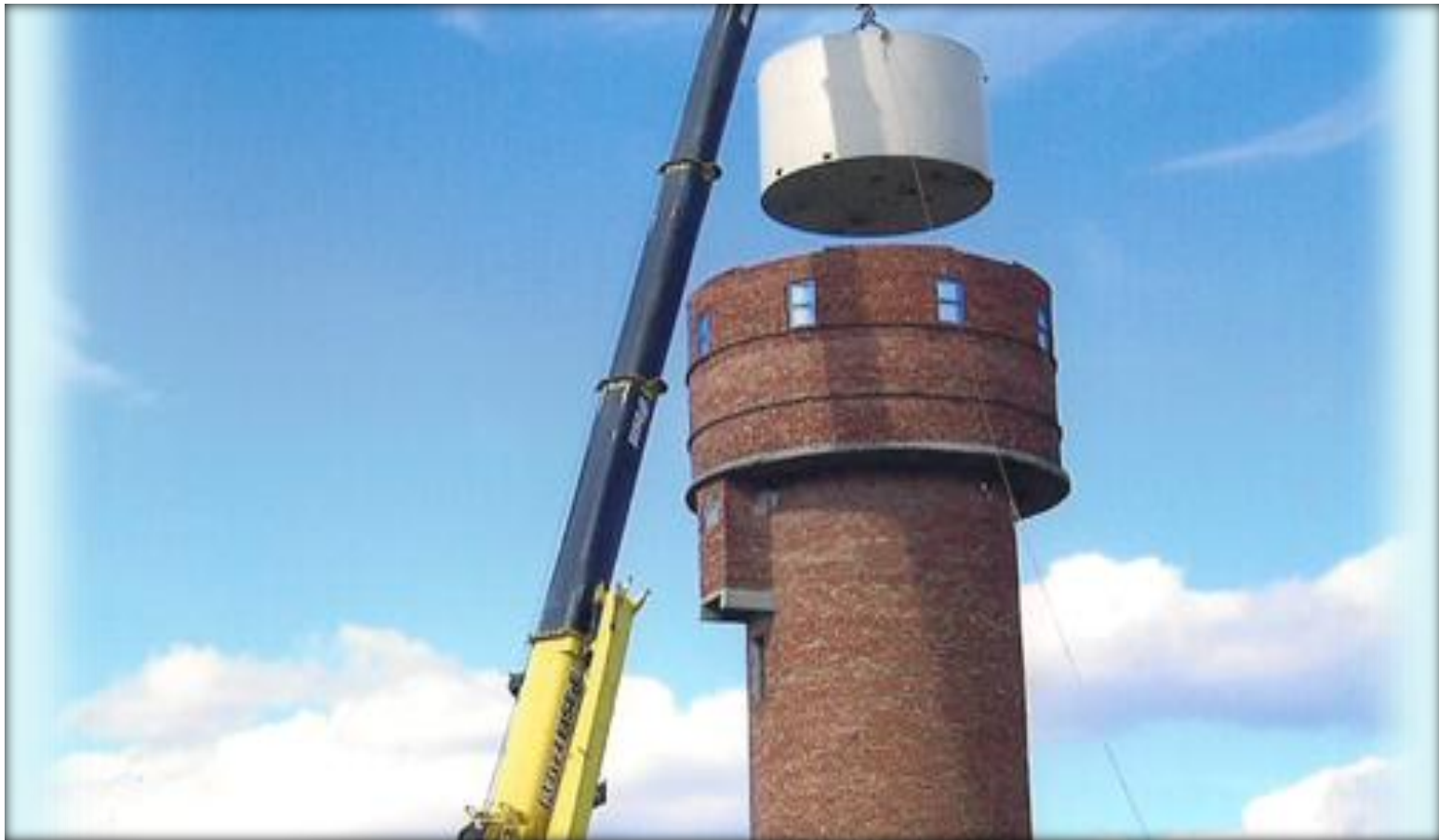
ФГУ комбинат «Атлас» Каменский район пос. Молодежный. Водонапорная башня
