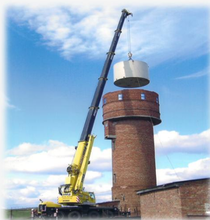
ФГУ комбинат «Атлас» Каменский район пос. Молодежный. Водонапорная башня
